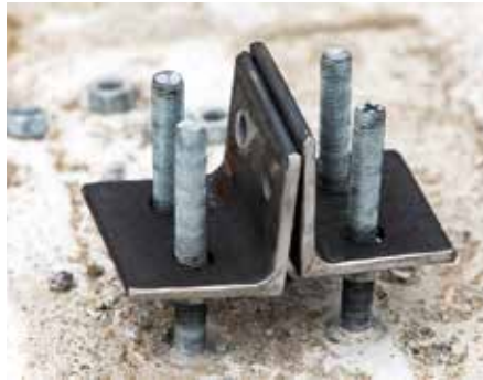
Aansluiting ankers zonder voetplaat.
