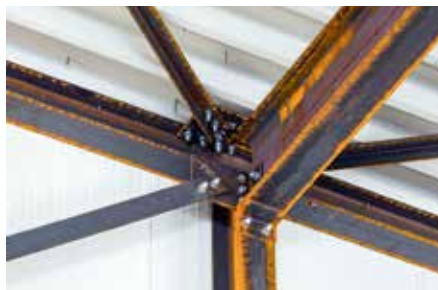
Onbehandeld staal en geschroefde daklaag.
