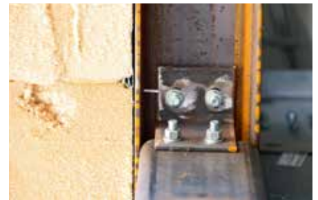
Gevel pir noch pur: maar geperst en gezout houtwol.
